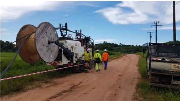
*Réalisation de tranchées et pose de câbles (source : Voltalia)*
